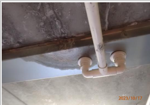
Spesialopplegg fra en bygd innvendig takrenne.
