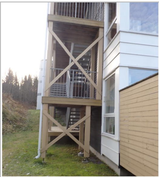
Trapperom for blokk nord.
