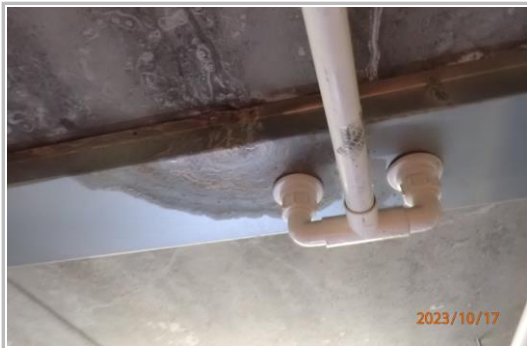
Spesialbygd avløp fra plassert takrenne.
