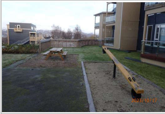
Uteområdet over parkeringskjeller nord.
