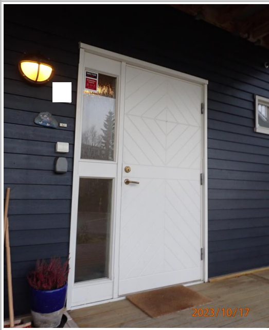
Entredører står innunder svalgangtak og er i god forfatning.
