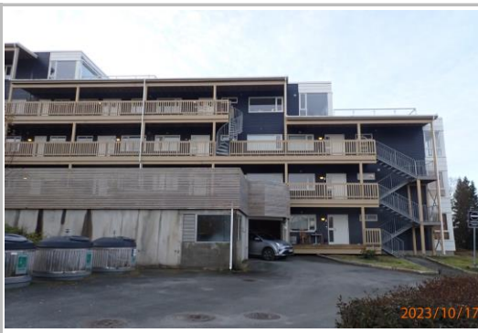
Fasade med innkjøring til ett av parkeringsanleggene
