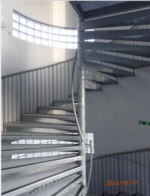
Innvendig trapperom for blokk nord.
