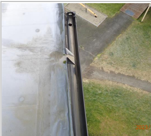
Utvendig takrenne på småtak.
