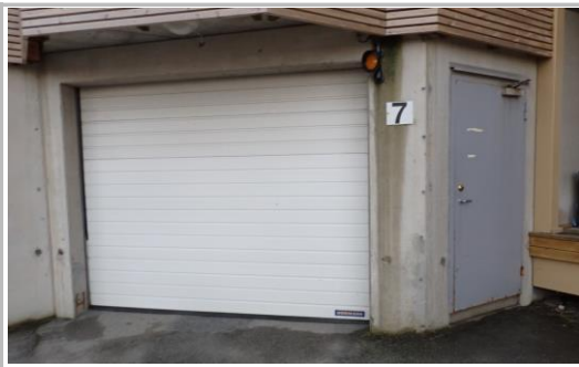
Garasjeport med elektrisk åpning.
